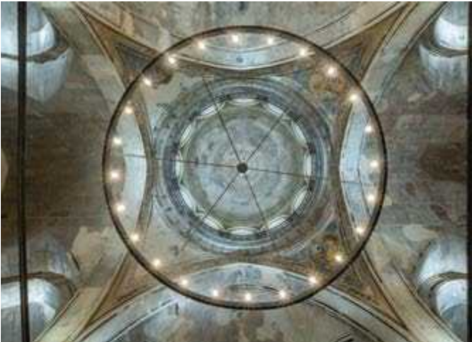
Resim 22. Kayseri Şehir Kütüphanesi (Meryem Ana Kilisesi Kubbesi)
