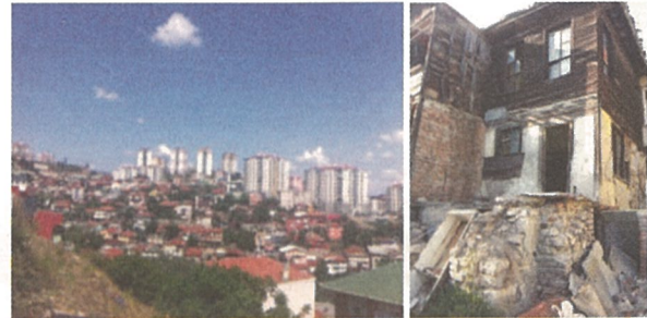
Resim 1. Çalışma alanı ve yıkılmak üzere olan bir konut örneği
