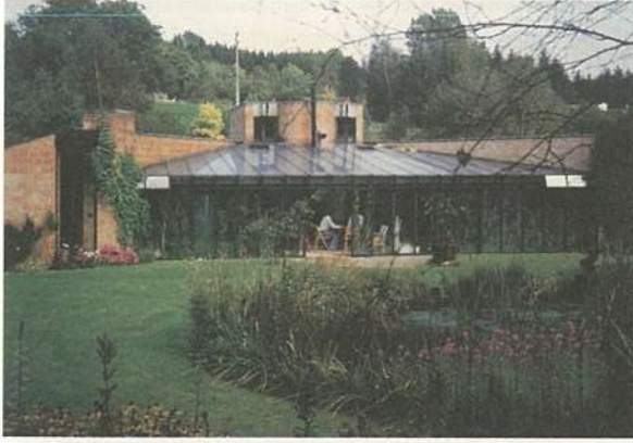
Şekil 11. Maison Quinet'in Greenhouse Görünüşü
