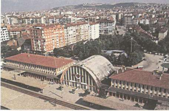
Şekil 1. Eskişehir Gar Binası
