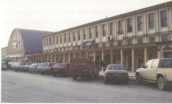
Şekil 2. Gar Binası dış mekân
