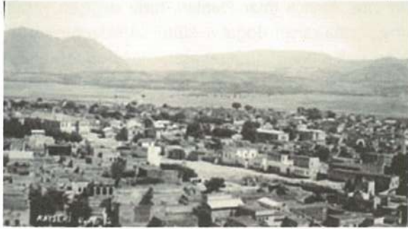
Şekil 2 Hatiroğlu Camii ve önündeki yeni açılan bulvar
