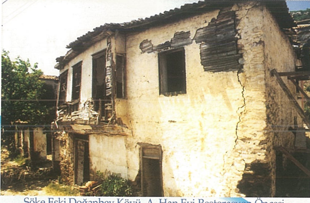
Söke Eski Doğanbey Köyü A. Han Evi Restorasyon Öncesi
