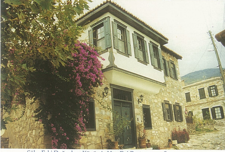
Söke Eski Doğanbey Köyü A. Han Evi Restorasyon Sonrası
